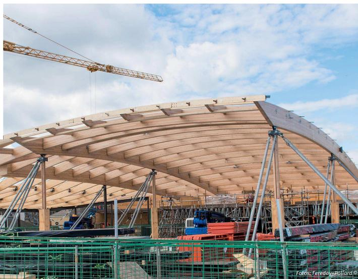
Die spektakuläre Tonnendach-Holzkonstruktion der WIEHAG aus Österreich für die Londoner Crossrail Bahnstation Canary Wharf hatte 2016 international große Anerkennung gefunden. Danach kam der Anschlussauftrag für die Abbey Wood Station. Sie bildet die Endstation der Crossrail-Linie. Der Holzschutz für das Tragwerk aus Brettschichtholz erfolgt erneut mit Remmers Produkten.
